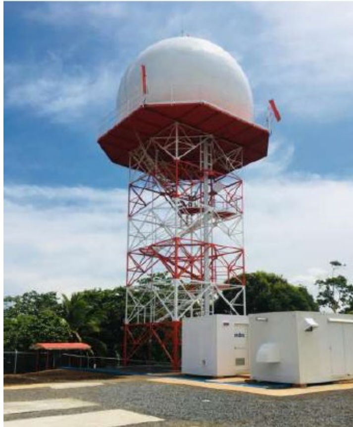
EQUIPOS RADAR PSR/MSSR-S/ADS-B, AEROPUERTO DE BLUEFIELDS
