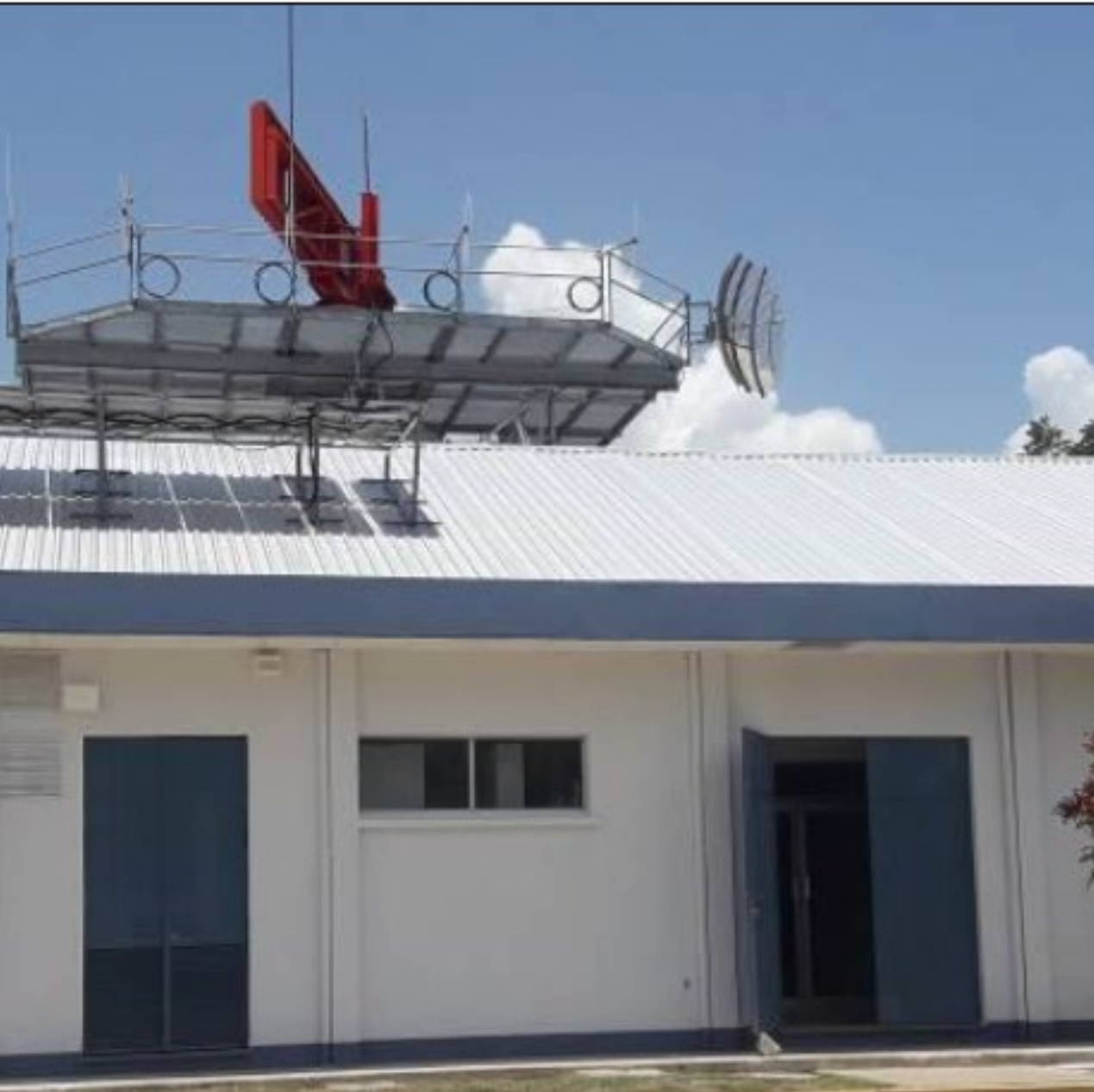
EQUIPOS RADAR MSSR-S/ADS-B, CERRO NIKTUN
